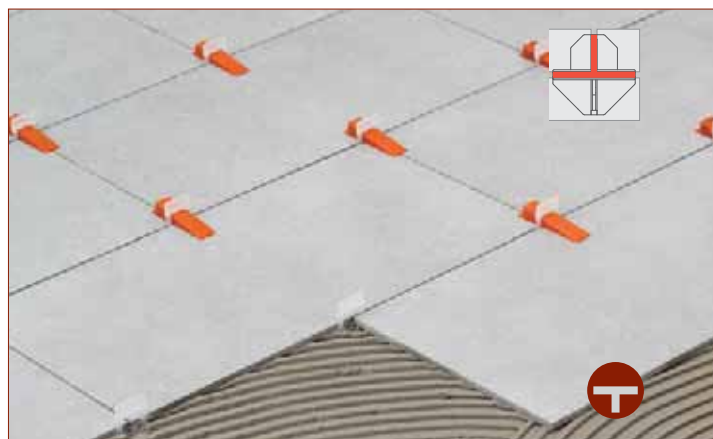
UTILIZZO CON POSA A "T" SULL'INCROCIO PIASTRELLA USE WITH "T" LAYOUT ON TILE INTERSECTIONS
